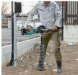
仮設電柱ポール設置、 その他現場作業に
