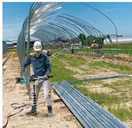
ビニールハウスの施工に
